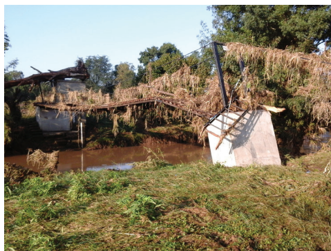
Сн. 10. Разрушен хидрометричен пункт на р. Ропотамо при с. Веселие
